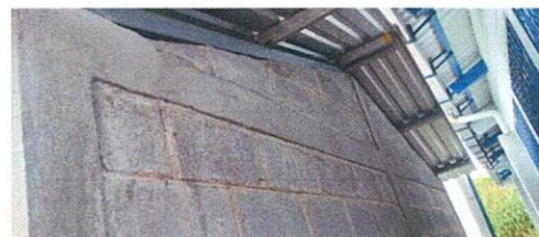
Foto 4: Finalización de techo de modulo.
