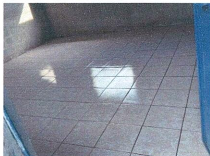
Foto 2: Finalización de cisado de piso ceramico modulo.
