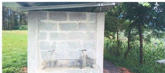
Foto 5: Finalización de lavamanos.
