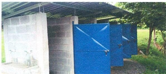
Foto 3: Finalización de techo sanitarios.
