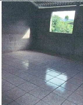
Foto1: Finalización de piso ceramico modulo.
