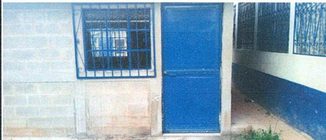
Foto1: Finalización de puerta de modulo.
