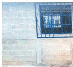
Foto 5: Finalización de valcones de modulo.
