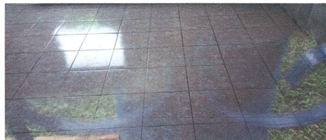
Foto 2: Finalización de piso ceramico modulo.
