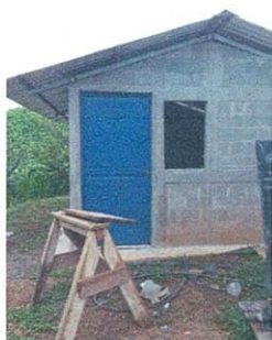
Foto 3: Finalización de puerta modulo.
