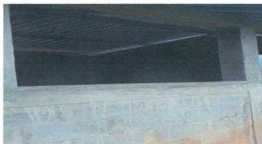
Foto 5: Finalización de ventanas modulo.
